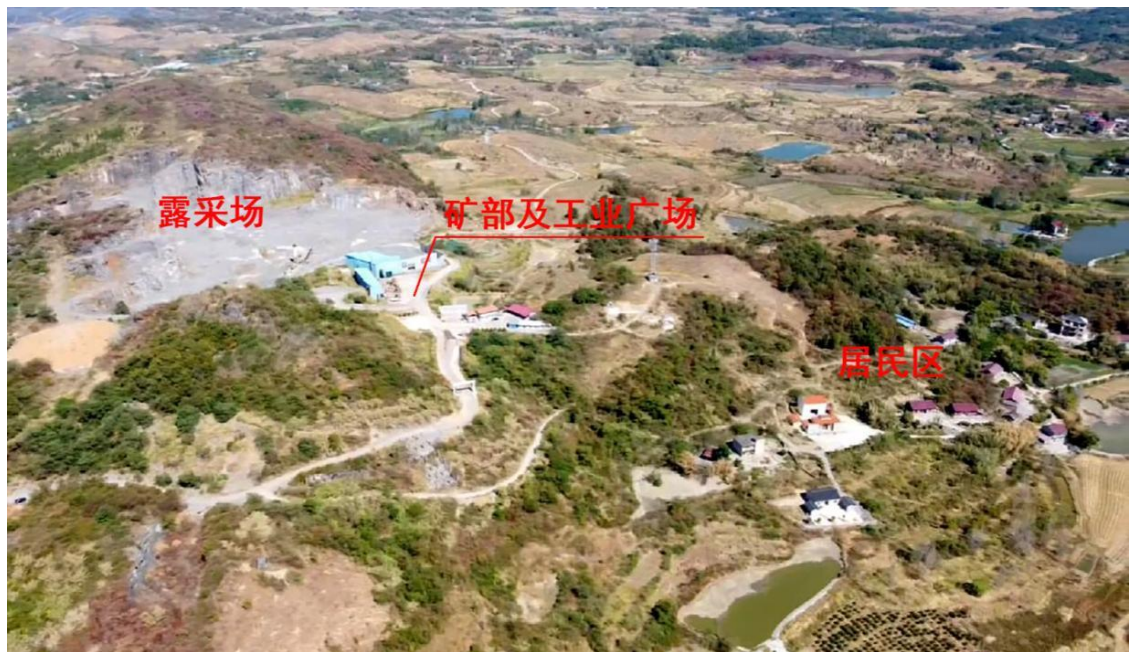
图 13 林生碎石场矿部及工业广场、露采场和最近居民区相对位置
