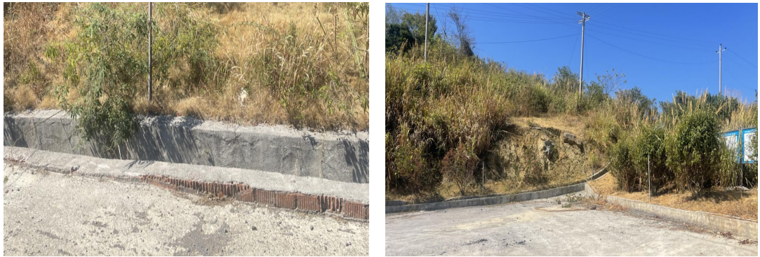
图 14 林生碎石场已建截水沟
