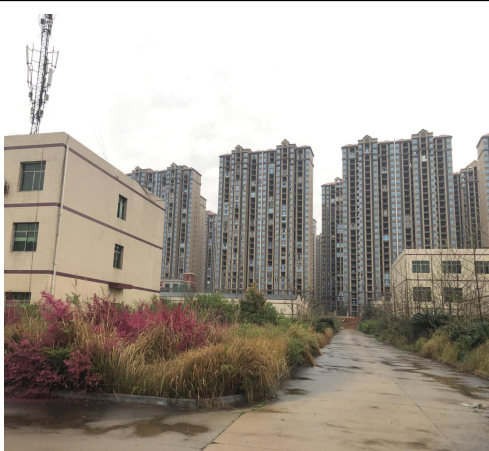
场内道路（原生产厂房未拆除前）
