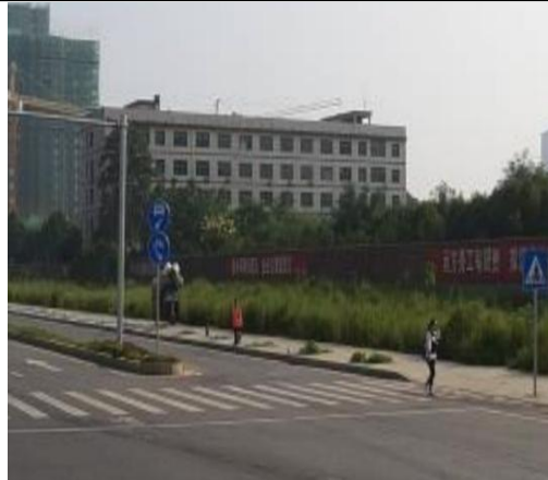
厂房西北部区域员工宿舍 （原生产厂房未拆除前）
